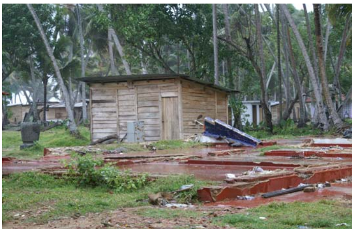
スリランカ南部・津波被害者の仮設住宅 2005年9月
